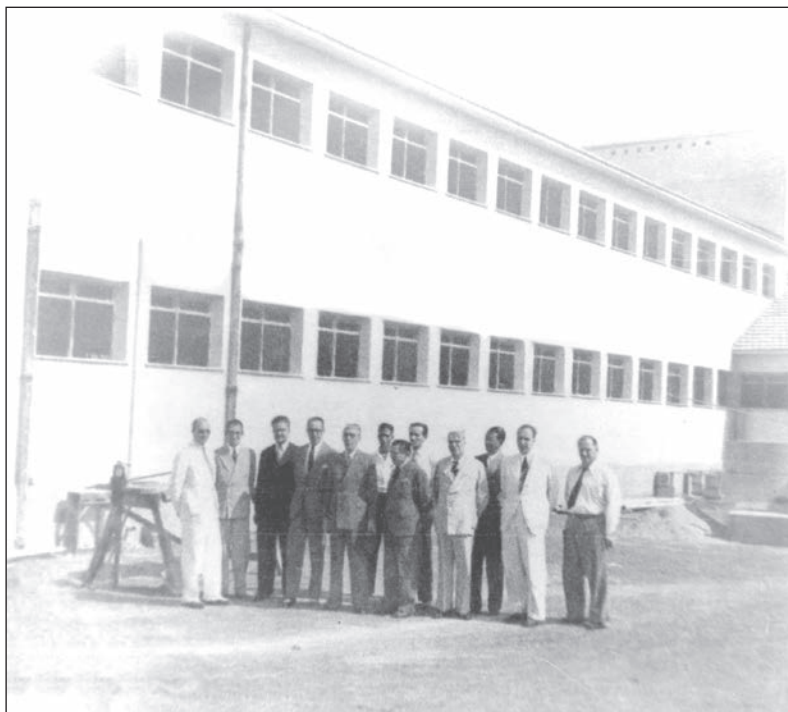
Foto 10. Equipe do Conselho Penitenciário do Distrito Federal em visita às obras da Penitenciária de Mulheres de Bangu e do Sanatório Penal, em 1942 (APB, 1942 a , s/p)
